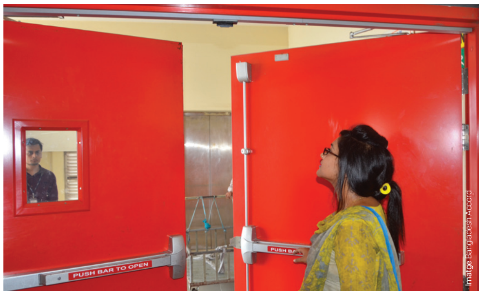
Noves portes contra incendis instal·lades en una fàbrica acollida a l'Acord de Bangladesh.
